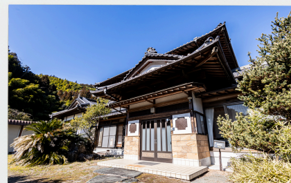
空き家を見学!
